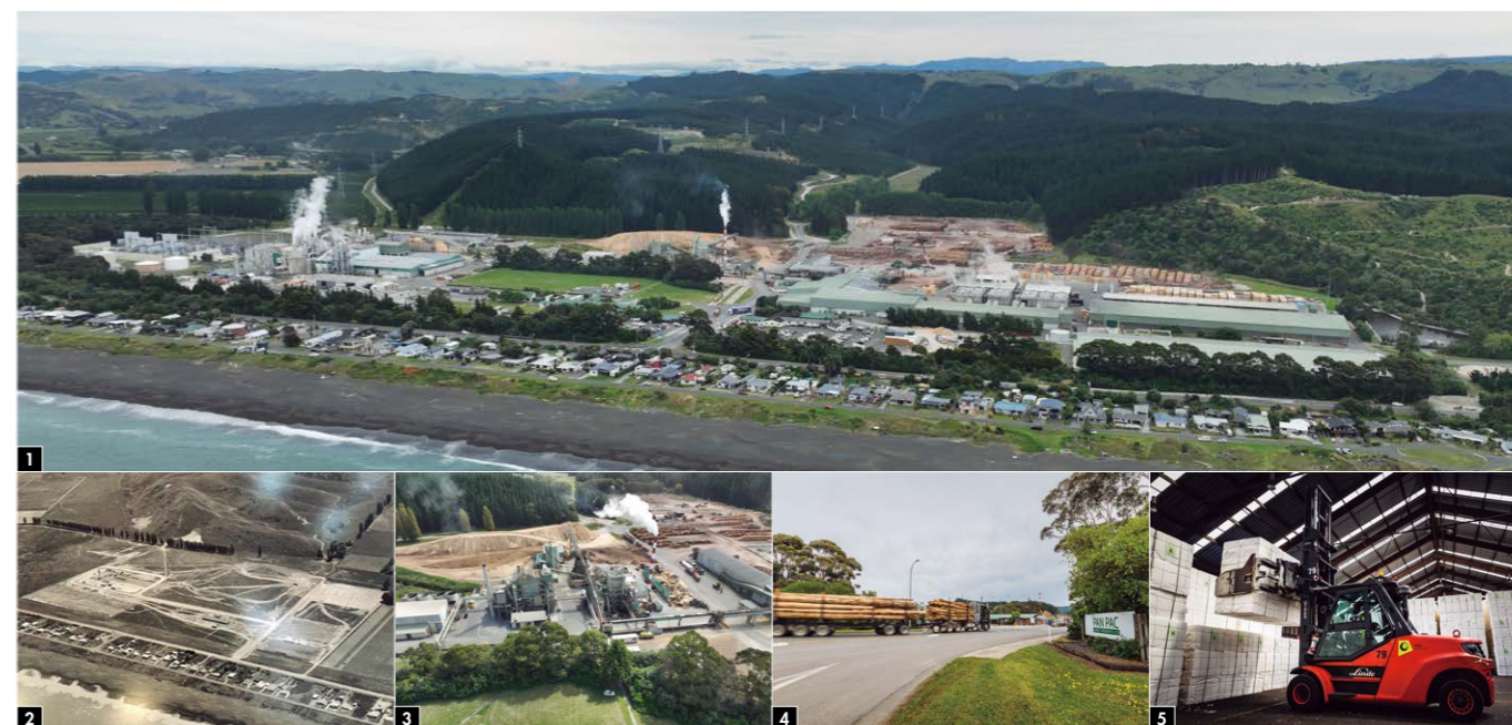
①現在のPan Pac。パルプ工場（向かって左側）、製材工場（右側）、奥の森林はPan Pacの自社林②1971年当時のPan Pac。建設当初の工場の航空写真③バイオマスボイラー。製材の生産工程で出る木屑等で蒸気を発生させ、製材の乾燥工程や自家発電に使用④ログトラックによる丸太の搬入風景⑤積出港であるネイピア港の倉庫。クランプリフトによるパルプの積み出し
