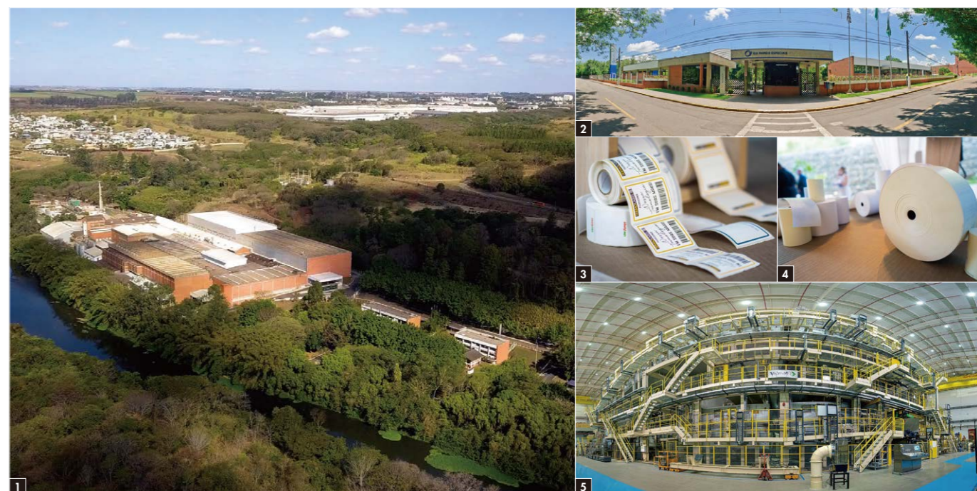
①2021年新設備導入後のパノラマ写真 ②会社正門 ③当社製品(ラベル用感熱紙) ④当社製品(レジ用感熱紙) ⑤完成後稼働を待つ新設備
