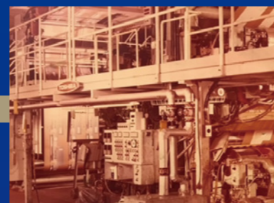
フレキシオン印刷機の設置
