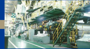
4号KSコーター稼働
