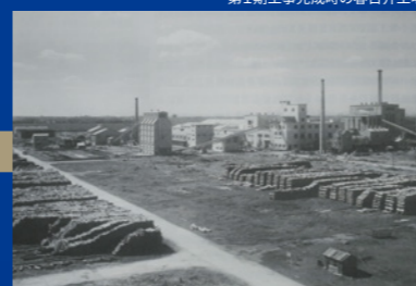
第1期工事完成時の春日井工場
