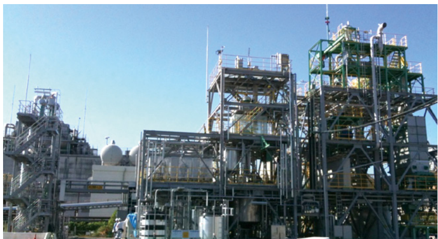
Bio-ethanol Plant (Kure Mill)
