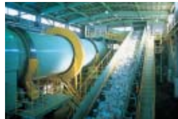
苫小牧工場のDIP設備
