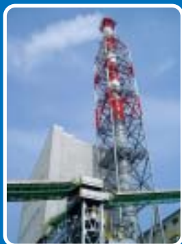
苫小牧工場RPFボイラー
