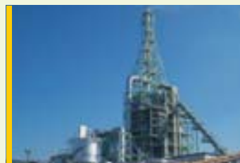
大分工場RPFボイラー
