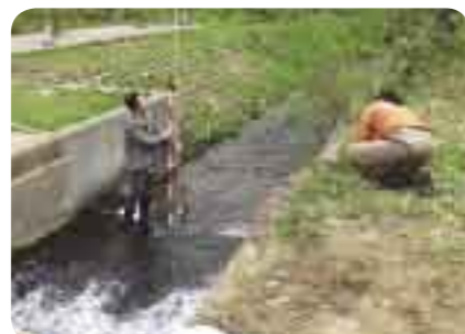
遡上を妨げる箇所に魚道を整備するための調査
