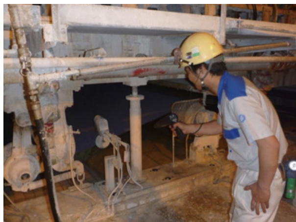
圧縮空気の漏れを調査(王子製紙 米子工場)
