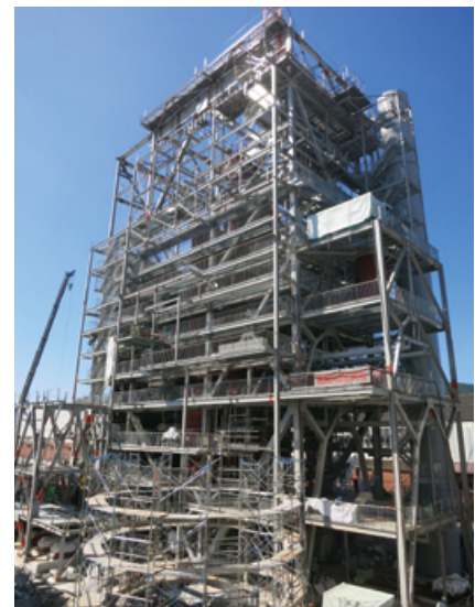
建設中のバイオマスボイラー (王子グリーンエネルギー日南/宮崎県日南市)
