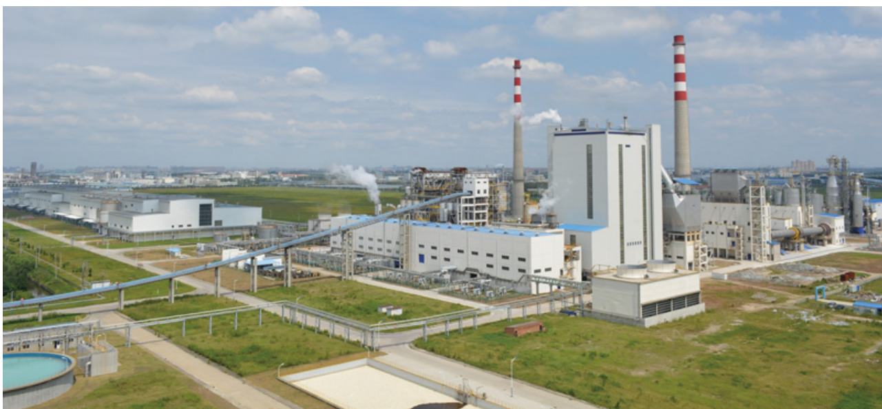
南通工場全景
