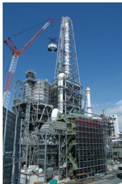
建設中の王子マテリア 富士工場 バイオマスボイラー(静岡県)
