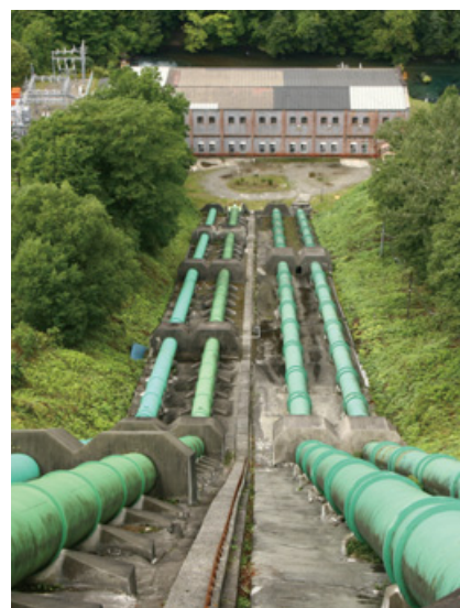
千歳第一水力発電所
