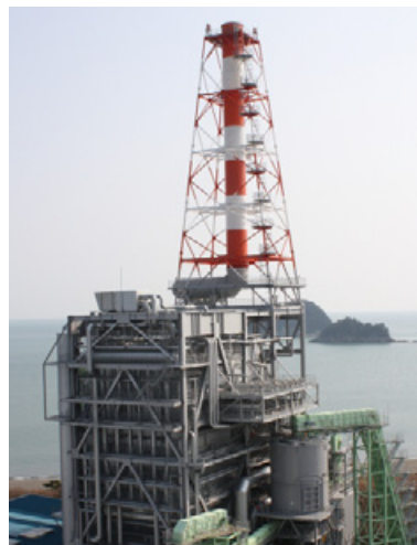
富岡工場 バイオマスボイラー
