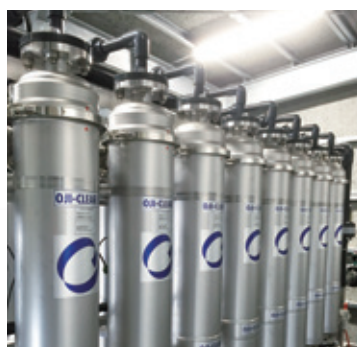
排水処理システム
