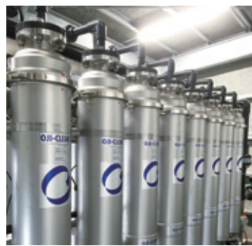
排水処理システム
