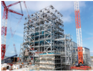
建設中のバイオマス発電プラント エム・ピー・エム・王子エコエネルギー（青森県八戸市）
