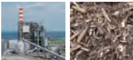
エム・ピー・エム・王子エコエネルギーのバイオマス発電設備 バイオマス燃料
