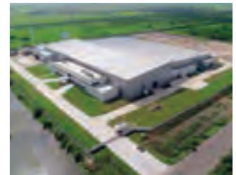
インド グジャラート州 アーメダバード 段ボール新工場
