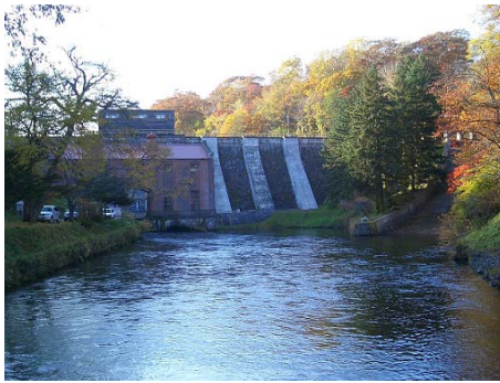
千歳第4発電所
