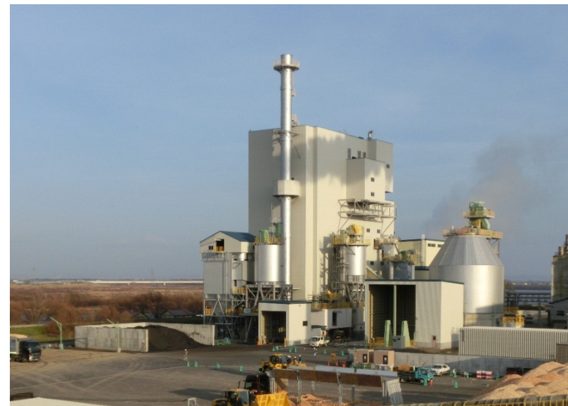
王子グリーンエナジー江別（試運転中のバイオマスボイラ）
