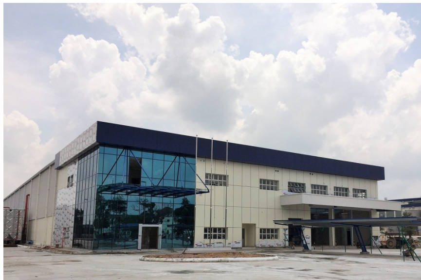
マレーシアで建設中の紙おむつ新工場
