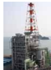
バイオマス発電設備イメージ (写真は、王子製紙富岡工場)
