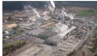
ニュージーランド CHHPP キンレース工場
