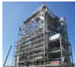
王子グリーンエナジー日南バイオマス発電設備（建設中）
