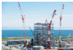
建設中のバイオマス発電プラント (エム・ピー・エム・王子エコエネルギー/八戸市)
