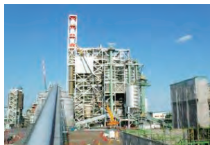
建設中のバイオマス発電プラント エム・ピー・エム・王子エコエネルギー/八戸
