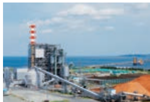
エム・ピー・エム・王子エコエネルギー /バイオマス発電設備(青森県)
