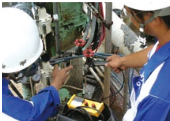
王子製紙(株)春日井工場での省エネパトロール エア漏れによる無駄がないかの確認
