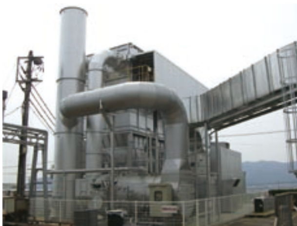
脱臭設備(新タック化成(株)豊中工場)
