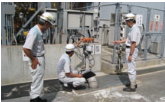
防液堤排水ポンプ点検（王子製紙（株） 富岡工場）
