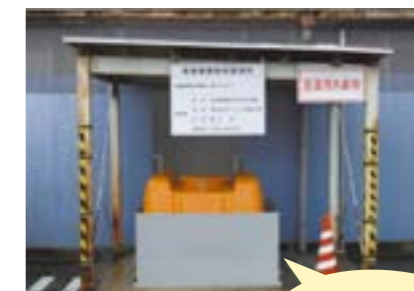
廃アルカリ用容器に 囲いを設けて、漏洩 に備えています
