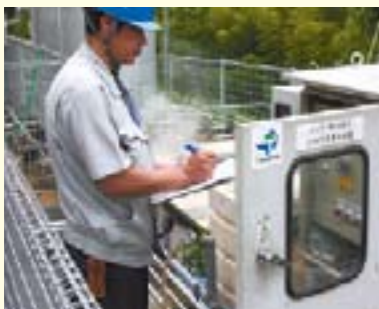
排水中和装置の点検
