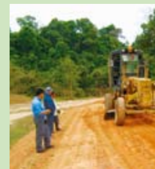
トンノイ村での道路建設(ラオス)
