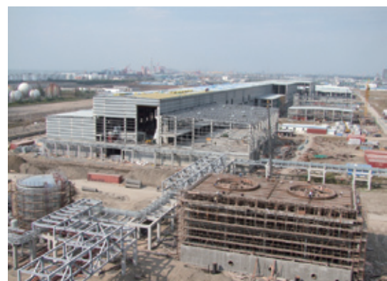
建設中の南通工場
