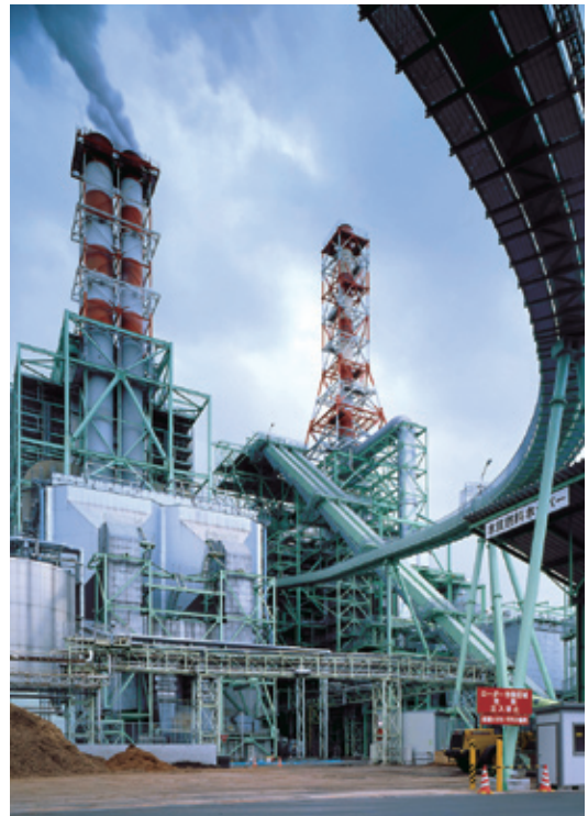
王子製紙米子工場の新エネルギーボイラー
