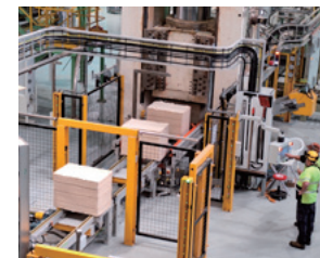
復旧稼働直後の工場パルプ設備
