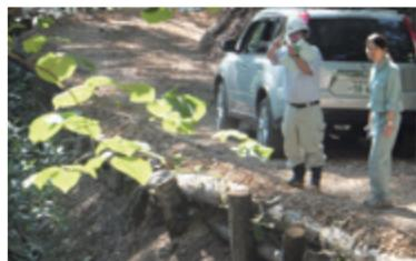
伐採した丸太で斜面を保護します
