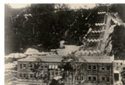
支笏湖畔・ナツソウの滝に建設した水力発電所
