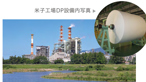
米子工場 全景
