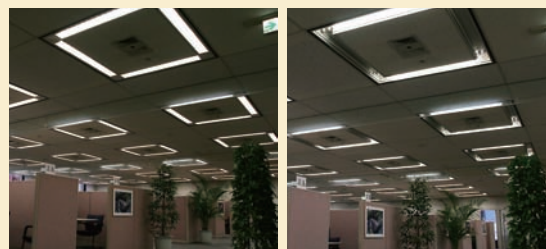
照明の省エネ化実施前(左)と実施後(右)。蛍光灯の本数を減らしても必要な照度を確保するためカバーを外した(本館執務室にて実施)。
