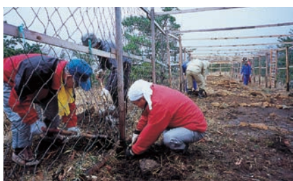
再生試験地に排水溝を作る参加者
