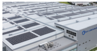
王子コンテナ桤木工場の太陽光パネル (発電した電力は段ボール生産等に使用)
