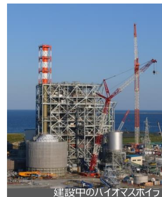
建設中のバイオマスボイラ
