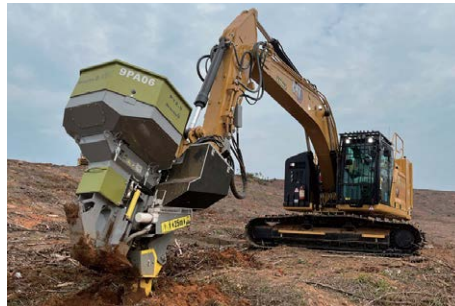
鋤入れ作業中の自動植付機
