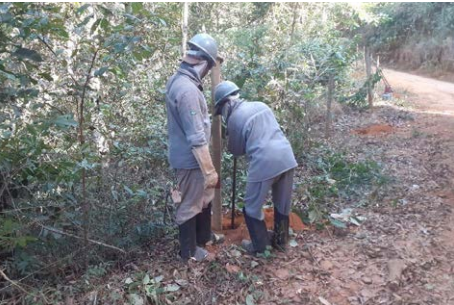
フェンスの設置
